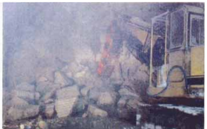
写真-4 フレーカによる二次破碎
