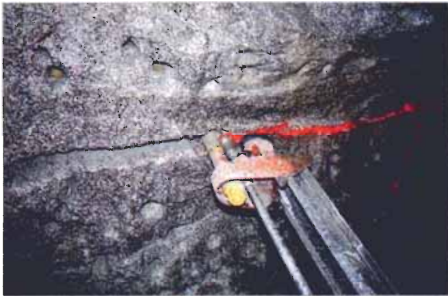
写真-1 連続孔穿孔状況
