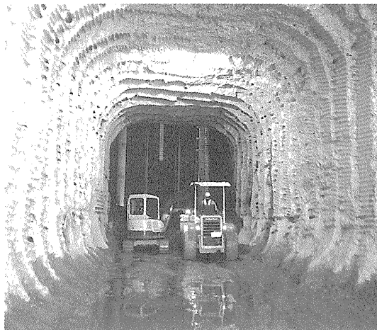
写真—2 ブレカ破碎完了状況
