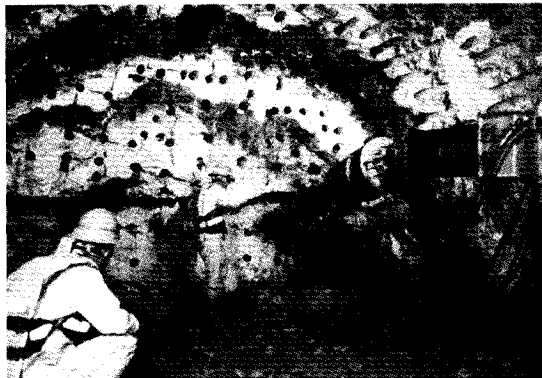
写真-2 A避難連絡坑における割岩状況
