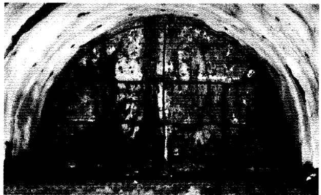
写真-1 穿孔後の切羽(上二河トンネル)
