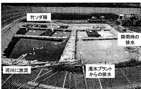
写真 5.1.3 竹ソダ式最終沈殿池
