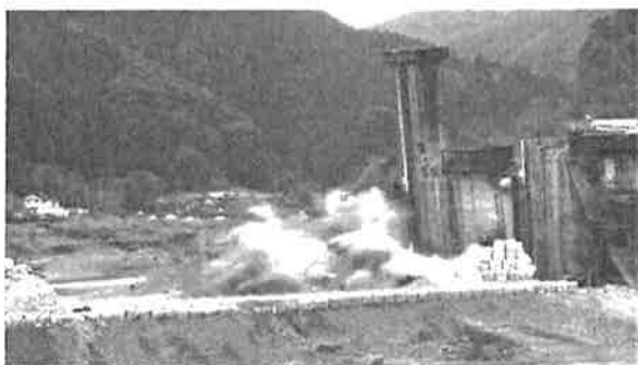
写真一3 P2倒壊発破 発破の瞬間
