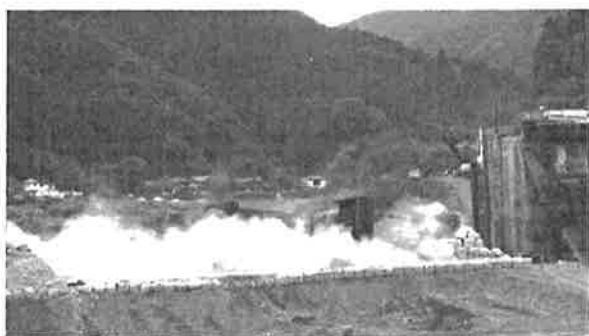
写真一4 P2倒壊発破 倒壊の瞬間
