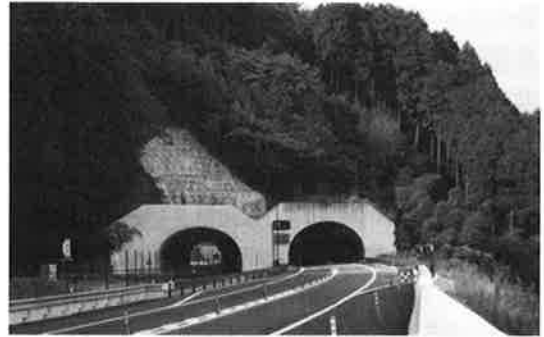
写真-6 起点側坑口全景
