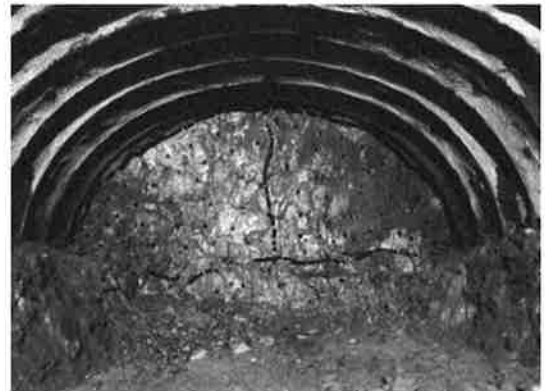
写真-3 連続孔・割岩孔完了
