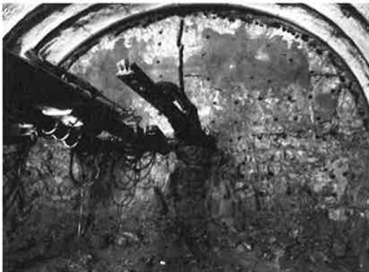
写真-2 連続孔・割岩削孔状況(ドリルジャンボにSABロッドを付けて孔や溝を掘削)
