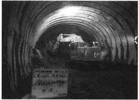
写真-5 2次破碎状況(割岩された岩盤を大型ブレイカーでさらに破碎)
