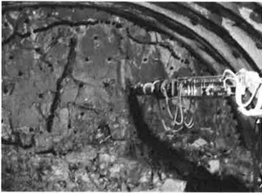
写真-4 1次破碎状況(掘削した孔に油圧くさびを差し込んで岩を破碎)
