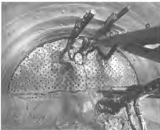
写真-1 連続孔、割岩孔の施工状況
